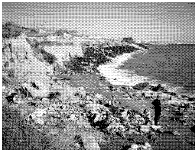
Il tratto di litorale dove nei giorni scorsi è affiorato l'impianto fognario
