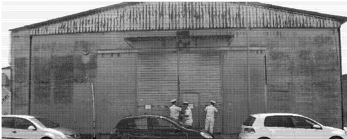
Il capannone in muratura e con la copertura in eternit per il quale il gip Lino ha disposto il sequestro eseguito dai militari della Capitaneria di porto
